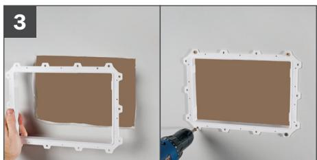
Insérer le cadre, avec le rebord allongé dirigé vers l'intérieur, dans le trou et visser le cadre au panneau de revêtement à travers les trous pratiqués.
