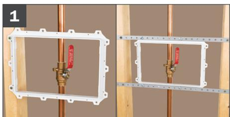
Suspendre le cadre, avec le rebord allongé dirigé vers l'extérieur, sur des barres de support ou directement sur les montants.
