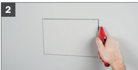
Mettre le cadre à niveau, tracer, retirer le cadre et couper le trou.
