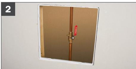
Aplique paneles de yeso al marco (el panel acabado requiere paneles de yeso de  $\frac{1}{2}$  de pulg. de espesor). Aplique mortero en todas las fisuras y separaciones para lograr una instalación acabada limpia.
