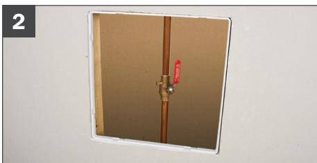
Poser des plaques de plâtre sur le cadre (le panneau fini est compatible uniquement avec les plaques de plâtre d'une épaisseur de 15,8 mm [½ po]). Appliquer un composé à joints sur tous les écarts pour obtenir une installation fine nette.
