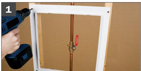
Suspendre le cadre sur des barres de support ou directement sur les montants. Mettre à niveau et fixer autour du dispositif/ de l'application nécessitant un accès et un service ultérieurs.
