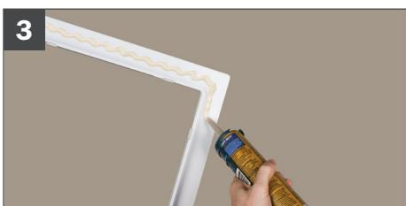
Aplique un cordón de adhesivo alrededor del perímetro del marco e introduzca según se muestra. Elimine el exceso de adhesivo.
